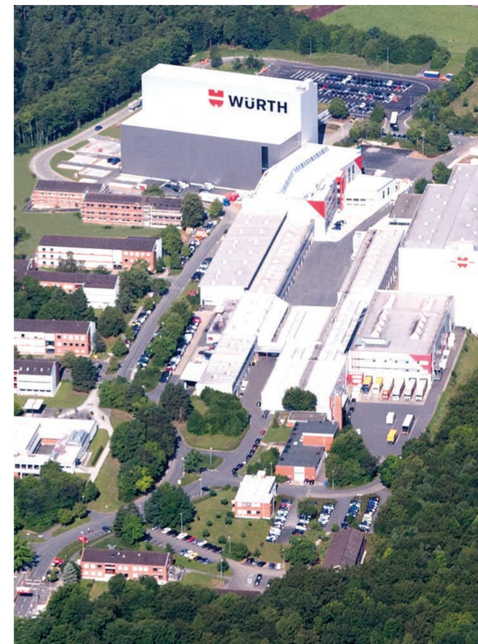
Magazyn centralny Würth Industrie Service GmbH & Co. KG: Park przemysłowy Würth w siedzibie firmy w miejscowości Bad Mergentheim
